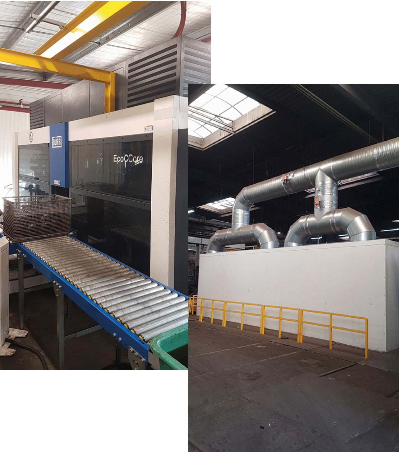
Un autre investissement important concerne une cabine de soudage pour les bogies afin de permettre un meilleur traitement des fumées, une meilleure ergonomie et de meilleures conditions de travail dans l’atelier.
